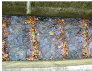
Verringerung der Funktionsfähigkeit durch Verstopfungen und Kies (Aquarius)
