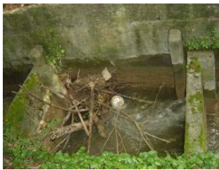
Verringerung der Funktionsfähigkeit durch Verstopfungen und Kies (Aquarius)
