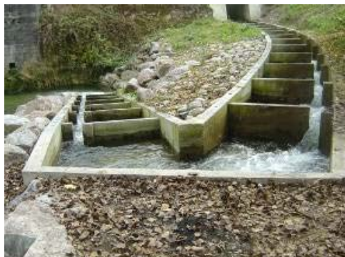
Töss: Ruhebecken bei Richtungswechsel des Schlitzfischpasses (Aquarius)
