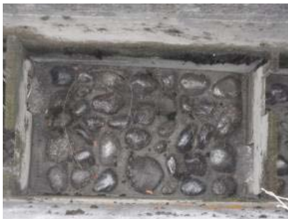
Einbetonierte Steine (Aquarius)
