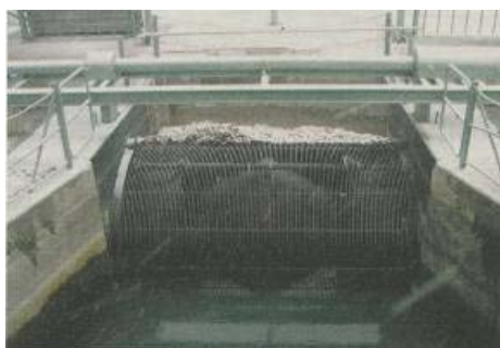
Trommelsieb mit lichter Stabweite = 25 mm (DWA, 2005)
