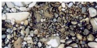
1 : Aucun colmatage : sous la couche de pavage se trouvent surtout du gravier et un peu de sable.
