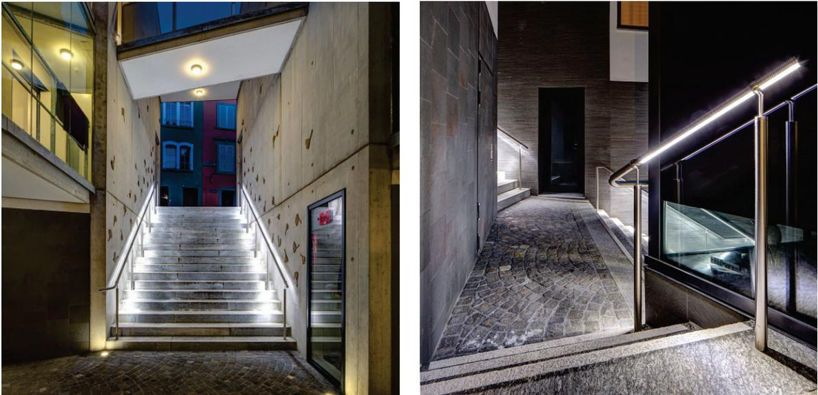
*Figura 18: Nel Quartier du Rôtillon a Losanna, le scale sono dotate di un'illuminazione supplementare a LED collocata nel corrimano. I singoli gradini sono inoltre muniti di strisce bianche antiscivolo che aumentano il contrasto (fonte: Città di Losanna)<sup>15</sup>.*
